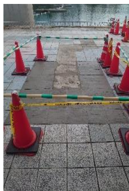
武庫川河川敷補修
