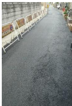
道路補修2箇所
