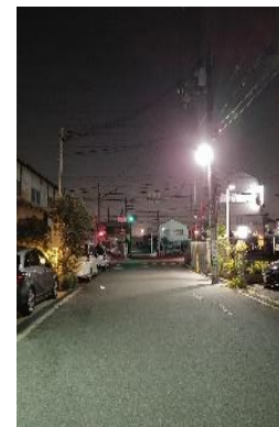
街灯設置4箇所
