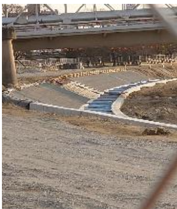
河川工事の確認
